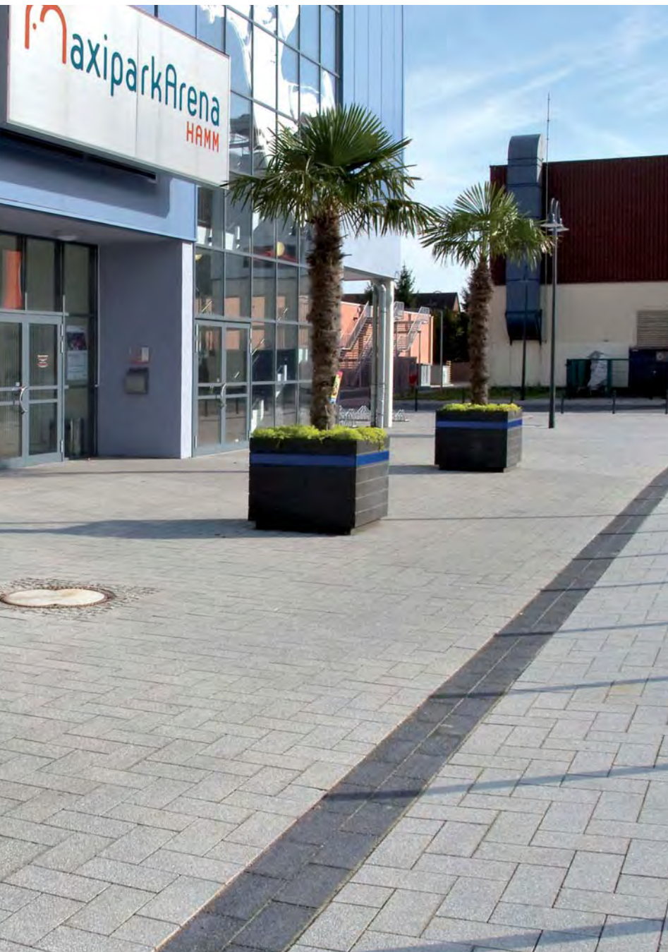
Integralpflaster mit Verschiebesicherung, wassergestrahlt, ohne Fase, 30x15 cm, granit-grau und basalt-anthrazit (Bänderung)
