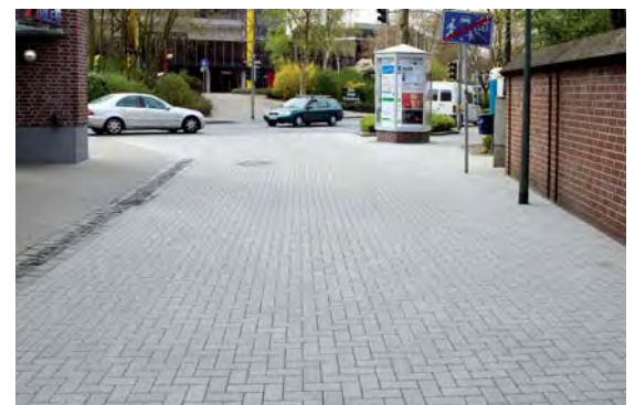
Integralpflaster mit Verschiebesicherung, mit Mikrofase, 20x10 cm, grau
