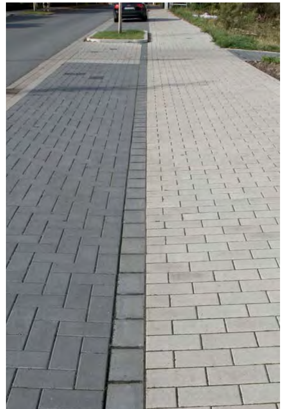
System 25-Objektpflaster, anthrazit und grau, Mittelbänderung erstellt mit System24-Objektpflaster
