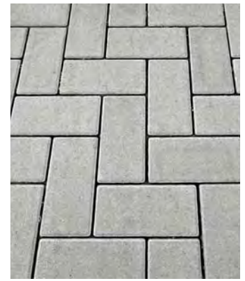
Pflaster mit leicht aufgeweiteter Fuge und filterstabilem Fugenmaterial
